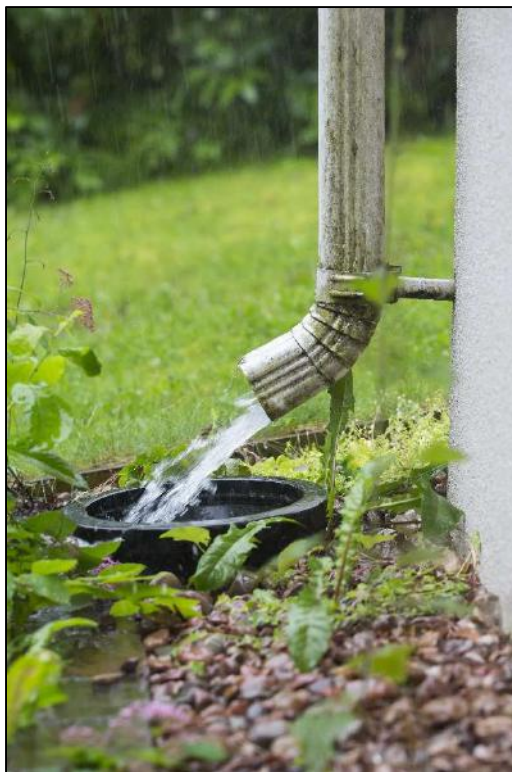
Figuur 94: Afkoppelen dakafvoer van het afvoerstelsel.
