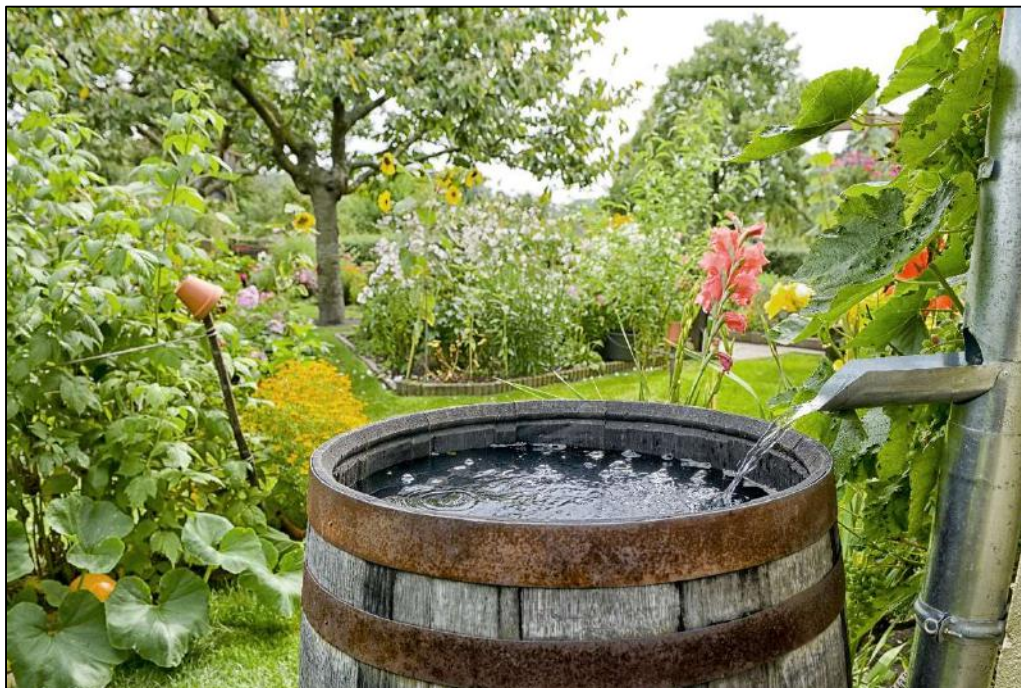
Figuur 95: Regenwaterton voor hergebruik van regenwater.
