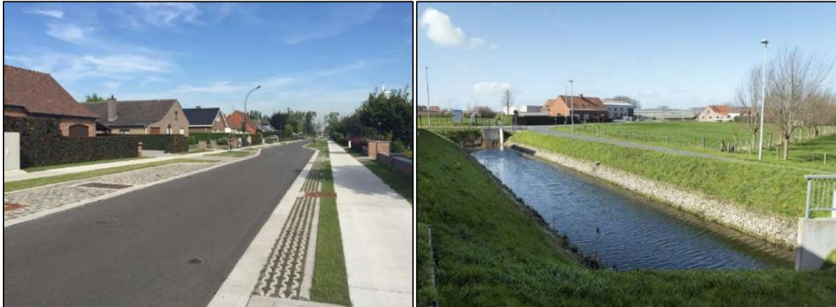
Figuur 96: Links: Lokale infiltratie wegverharding en fietspad. Rechts: Infiltratiebekken.
